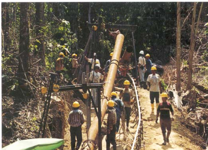
Monorriel Construcción Proyecto Arco 98
